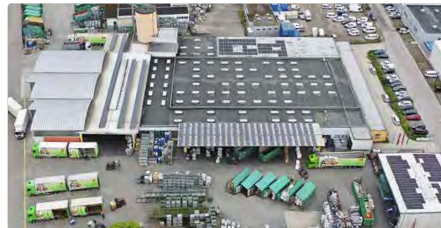
Abfall-Logistikzentrum in Wels
